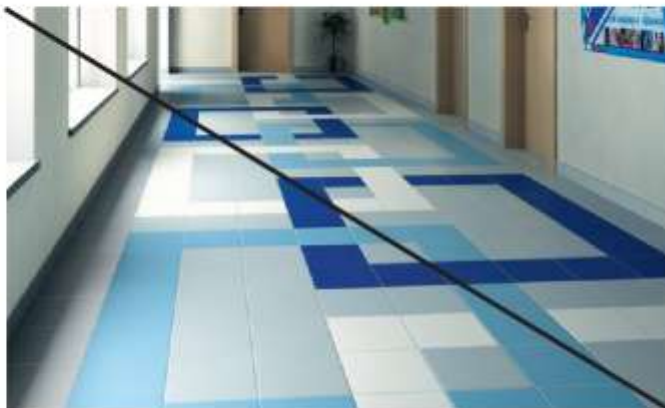
Плохо Цветные вставки из плитки
