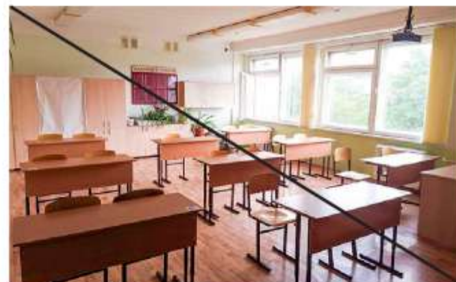
Плохо Линолеум под дерево
